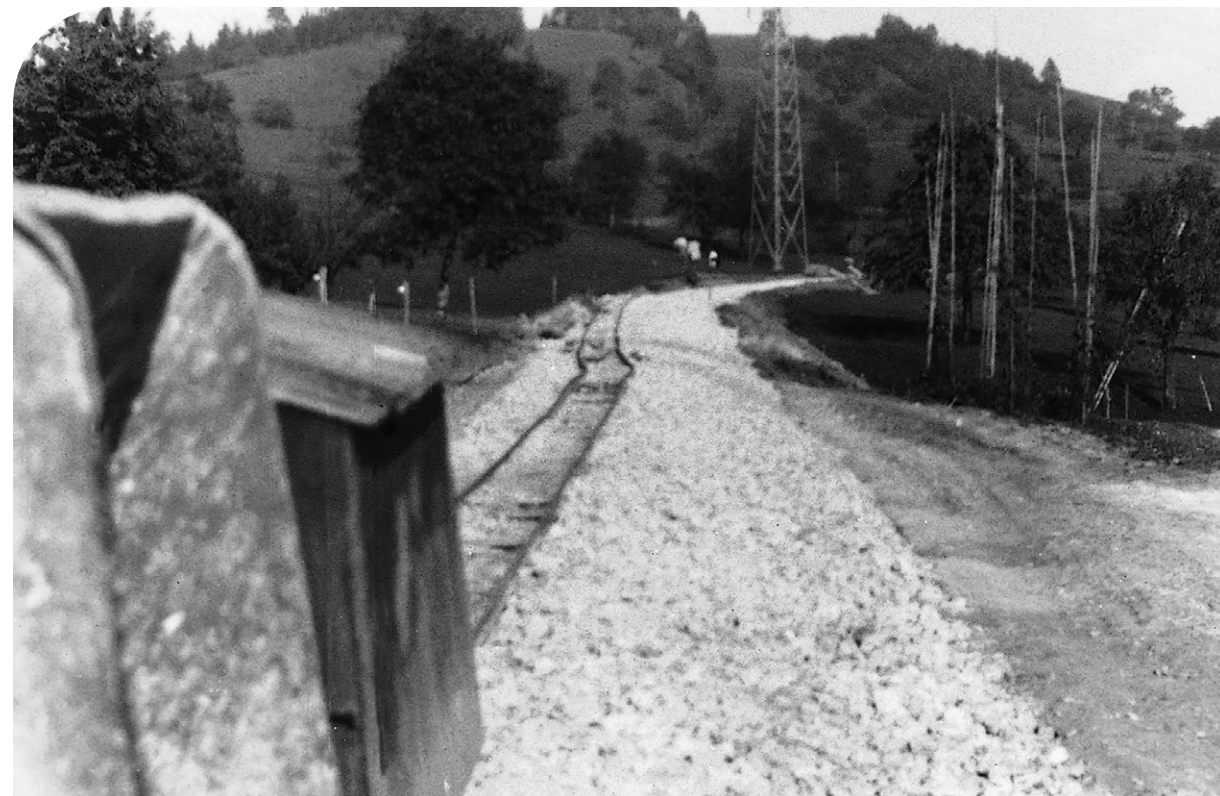
Bei der Güterregulierung entstanden über 45 Kilometer neue Wege. Auf dem Bild der Bau der neuen Heubergstrasse.
