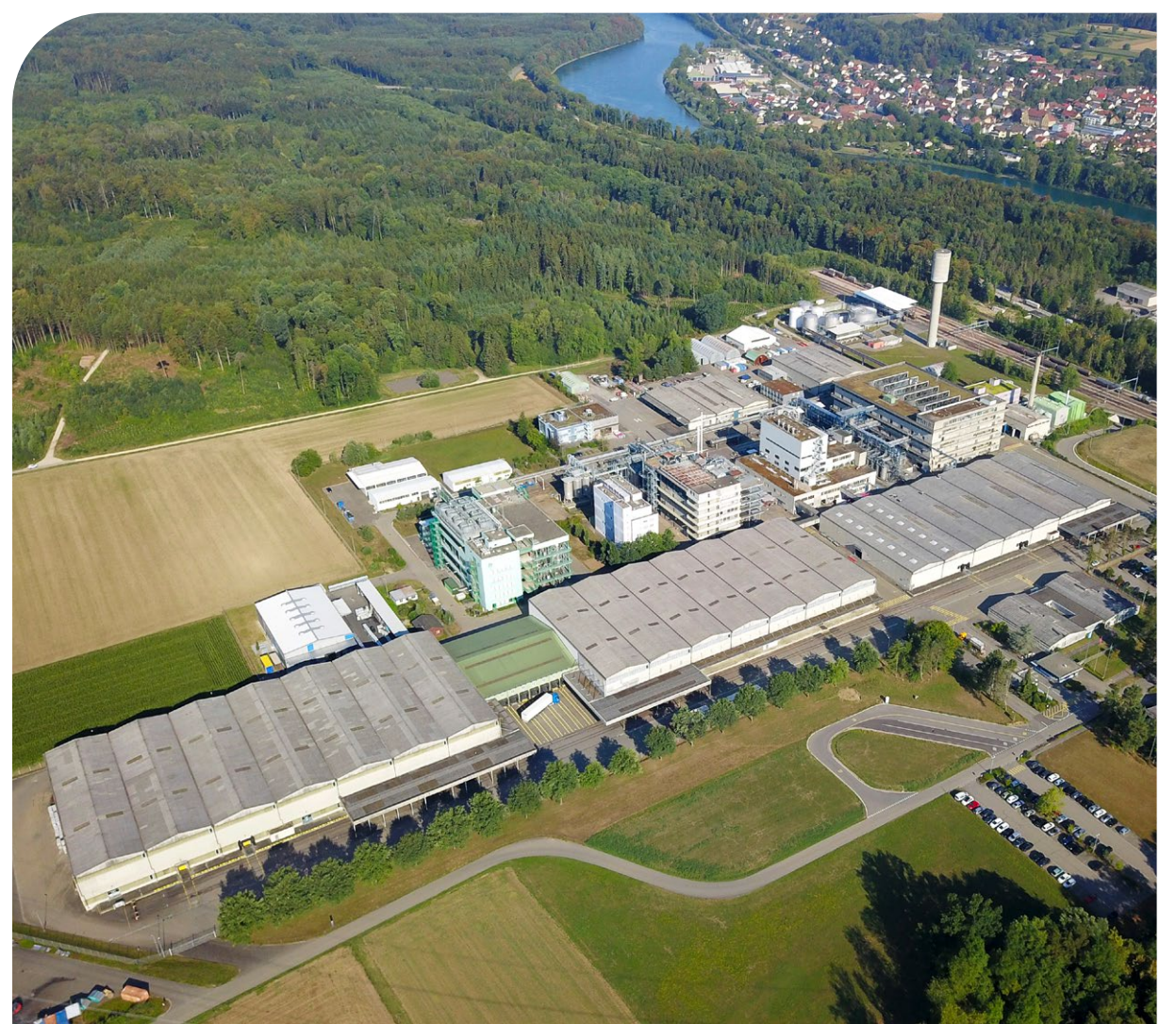
Die Industrie Hardmatt heute mit dem markanten Wasserturm und dem Rhein im Hintergrund. (Foto BASF)
