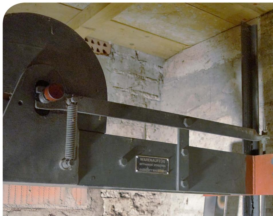
*Der Warenaufzug im Keller ist neben der Rampe der einzige noch sichtbare Teil der ehemaligen Dreschscheune. Mit diesem elektrisch betriebenen Lift wurde früher das Obst innerhalb der Dreschscheune umgelagert. Nach dem Bau des Lagers neben dem Volg diente der Lift dann ausschliesslich dem Transport von Getreide zwischen Erd- und Obergeschoss für die Befüllung der Dreschmaschine via Trichter.*
